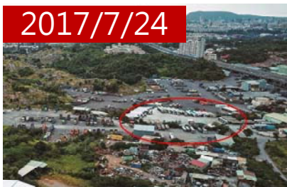
高雄市大寮區無牌化學槽車場 未向監理所申請
